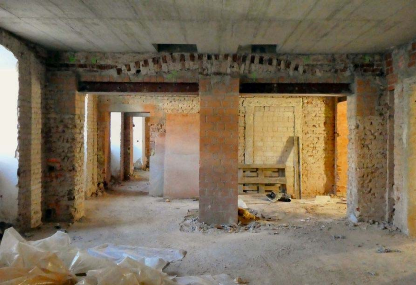
Teil der neuen Mensa
